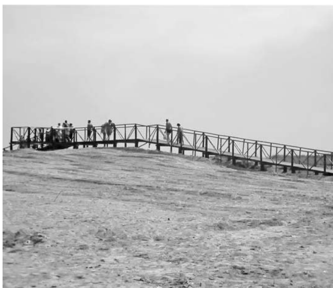
Los trabajos para la recuperación de las Playas del Este incluyen la construcción de pasarelas elevadas de madera en forma de puente, con la finalidad de evitar el paso de personas sobre la duna.
