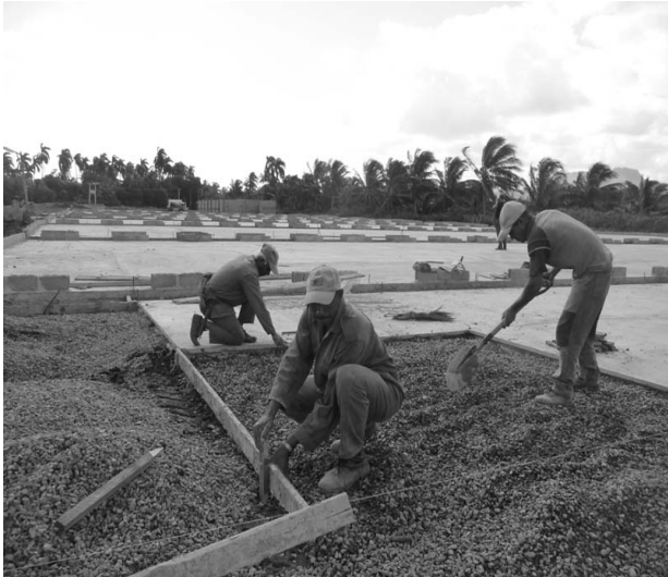
Fundición del undécimo patio de secadero. FOTO DEL AUTOR
