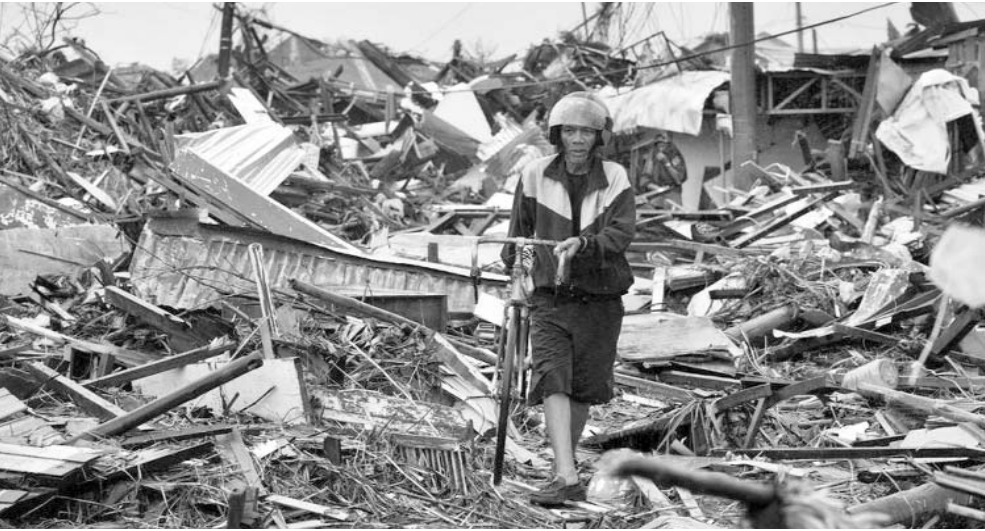
Los caminos están bloqueados por montañas de escombros, lo cual perjudica la llegada de la ayuda a las zonas devastadas. FOTO: REUTERS
