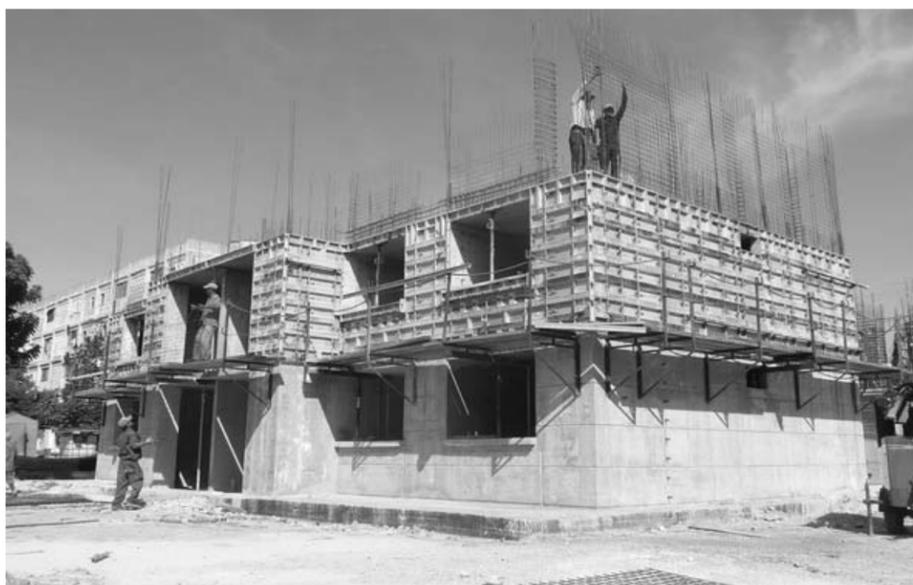
Concluido el primer nivel del sistema Forsa, el segundo permanece con el molde de formaletas empleado en la fundición del hormigón, y en el tercero se adelanta la malla de refuerzo.
