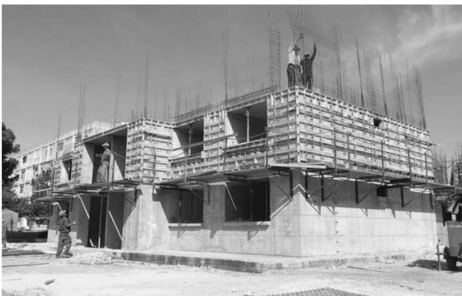
Concluido el primer nivel del sistema Forsa, el segundo permanece con el molde de formaleas empleado en la fundición del hormigón, y en el tercero se adelanta la malla de refuerzo.
