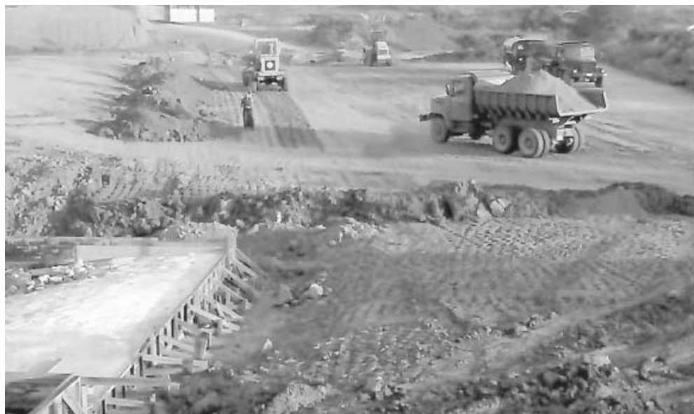
Desde la inauguración de la hidrorreguladora de San Juan y Martínez, en el año 2001, no se acometía una obra de esta envergadura en la provincia. FOTOS DEL AUTOR
