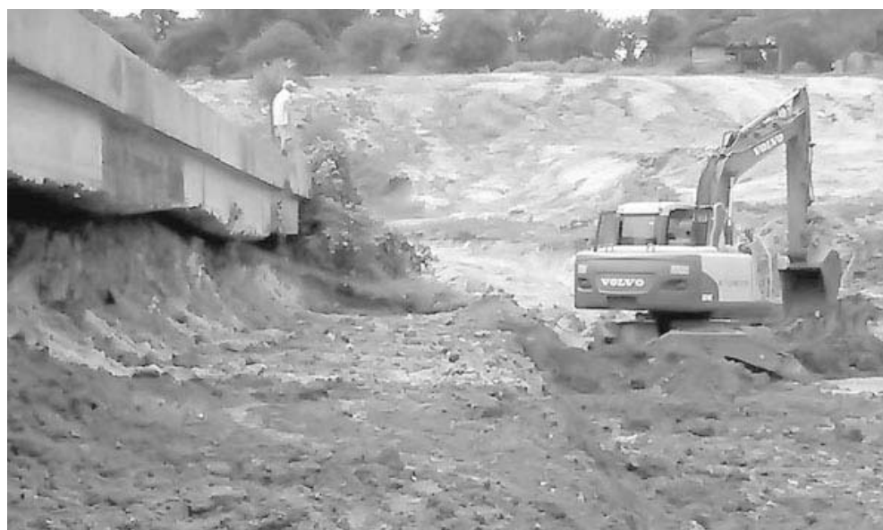
En jornadas de 10 horas diarias, que incluyen los sábados y los domingos, las fuerzas de la COAI #1 llevan a cabo la construcción de la derivadora.
