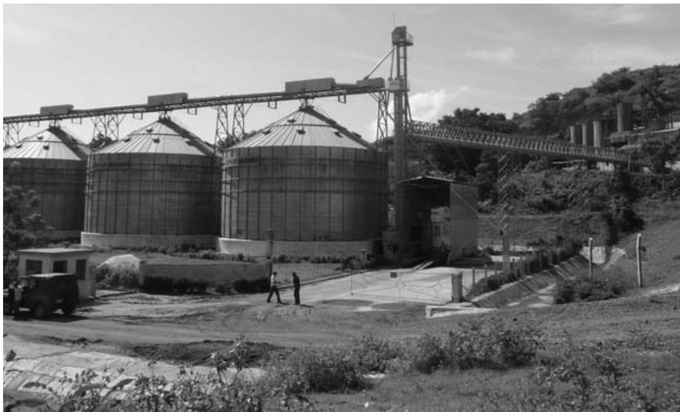
La vinculación aérea entre el molino (derecha) y los silos de almacenamiento aprovecha la irregularidad del terreno y evita la transportación en camiones del producto terminado. FOTOS DEL AUTOR
