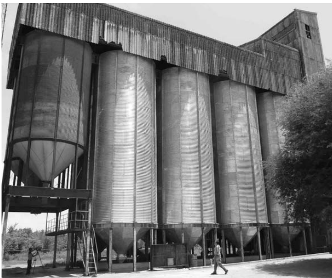
Desde el año pasado hasta la fecha han sido sustituidos 17 de estos enormes silos industriales.
