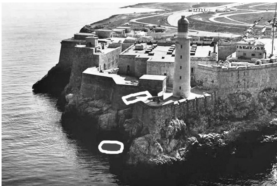
En el área saliente del Morro se montará la estructura de acero y aluminio que soportará la plataforma de saltos.
