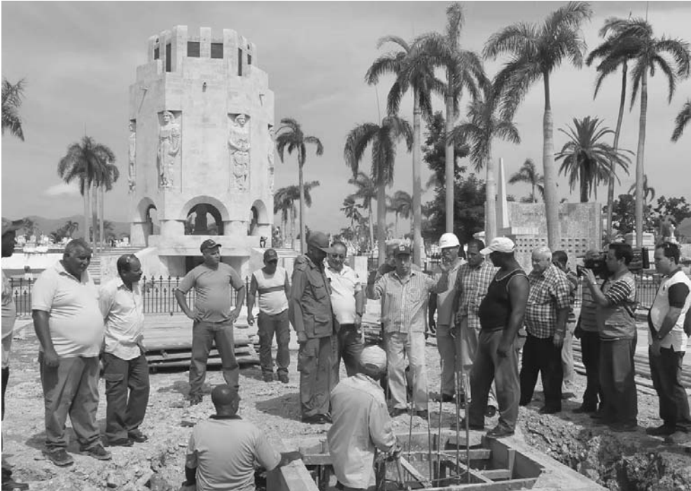
Machado compartió con los trabajadores que laboran en las reparaciones del cementerio Santa Ifigenia. FOTO: EDUARDO PALOMARES
