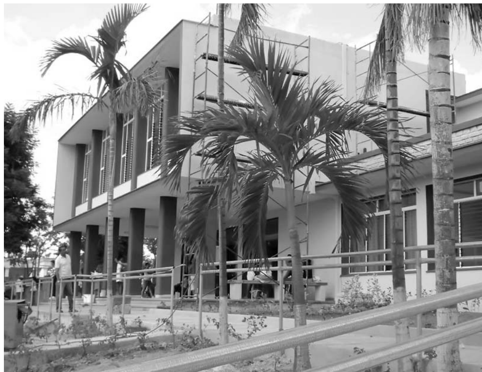
Con su nueva marquetería, pintura general y una jardinería más bonita, el Oncológico santiaguero ha quedado como nuevo. FOTOS DEL AUTOR
