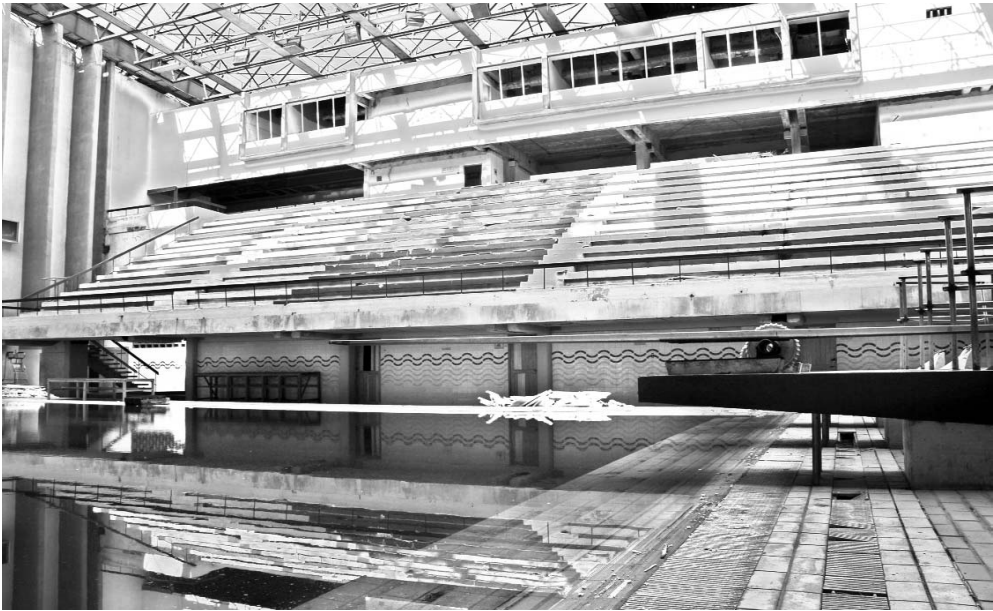
El Complejo de Piscinas Baraguá entre las instalaciones sometidas a reparación. FOTO: YAIMÍ RAVELO
