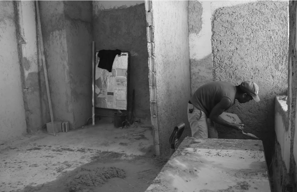
Cinco empresas constructivas, con sus roles y tareas bien definidas, llevan adelante la reparación.
