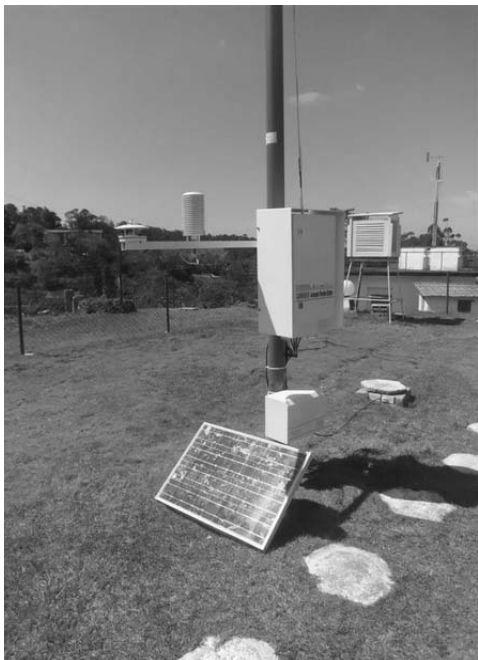
Topes de Collantes fue una de las estaciones beneficiadas con el proceso de automatización. FOTO: CORTESÍA DEL CENTRO METEOROLÓGICO PROVINCIA
