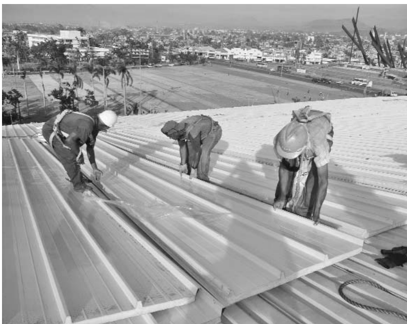
Un total de 525 tejas sandwich , de más de cien kilogramos de peso cada una, requiere el nuevo techo del Heredia.
