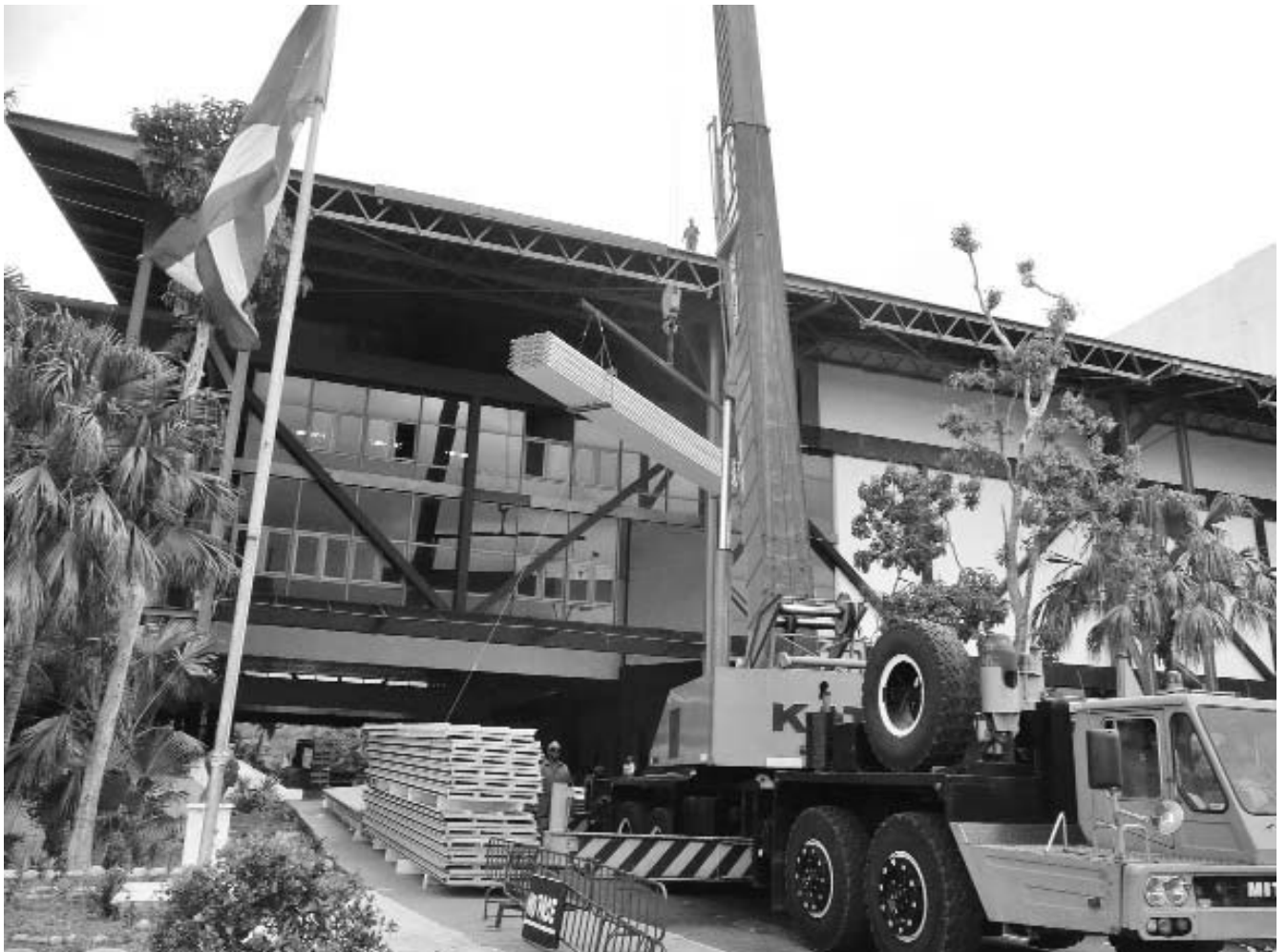
El izaje de las tejas con grúas supone un máximo cuidado. FOTOS DEL AUTOR
