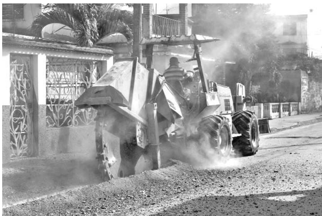
Metro a metro avanzan las brigadas en el trazado de los conductos y redes que mejorarán el servicio de agua a la población.
