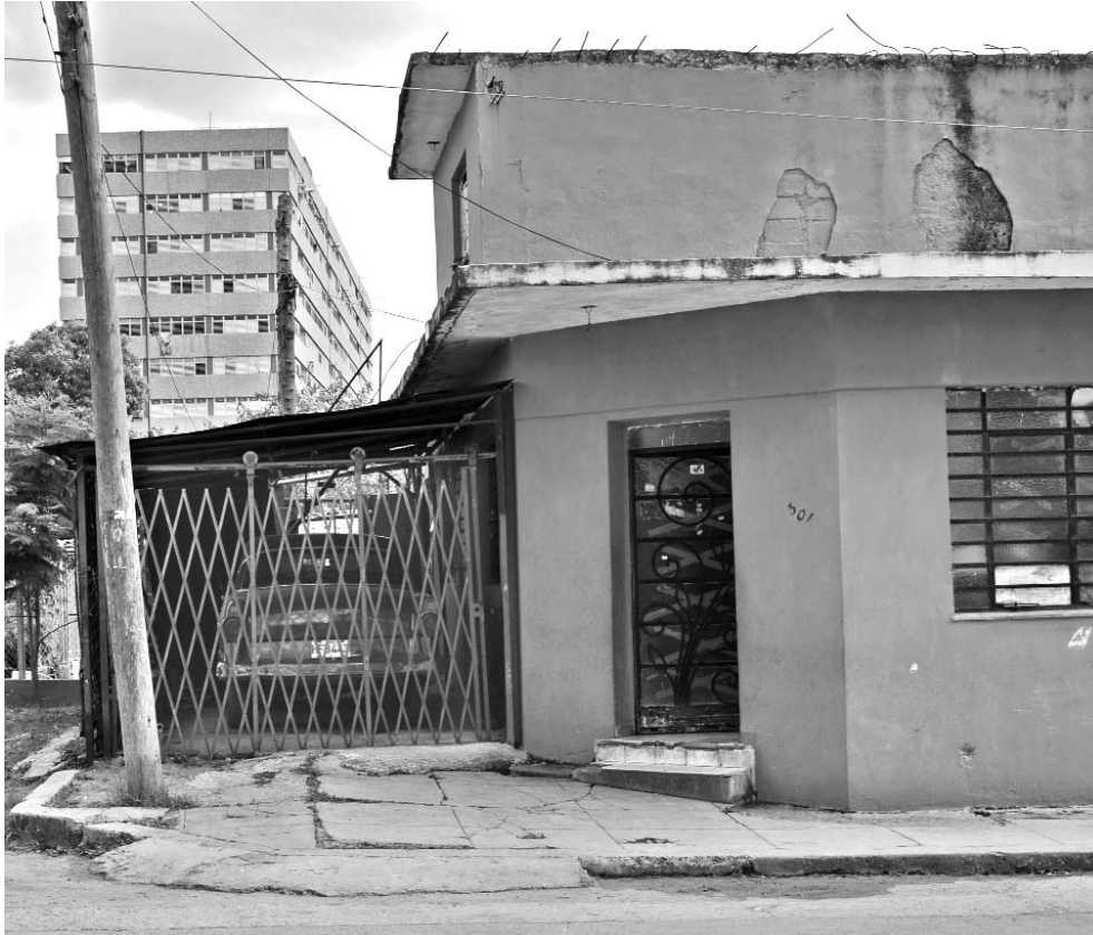
Las transformaciones en las fachadas y la ocupación de áreas de jardín figuran entre las violaciones más frecuentes al orden urbano. FOTO: ANABEL DÍAZ MENA
