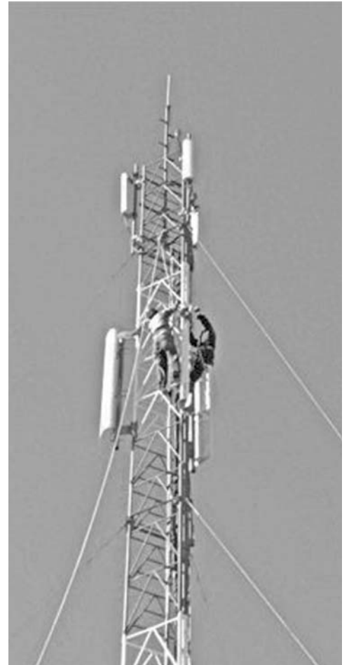
Alrededor de 80 torres y 90 grupos electrógenos con sus tanques de combustible auxiliares serán instalados. FOTO: UNIÓN DE FERROCARRILES
