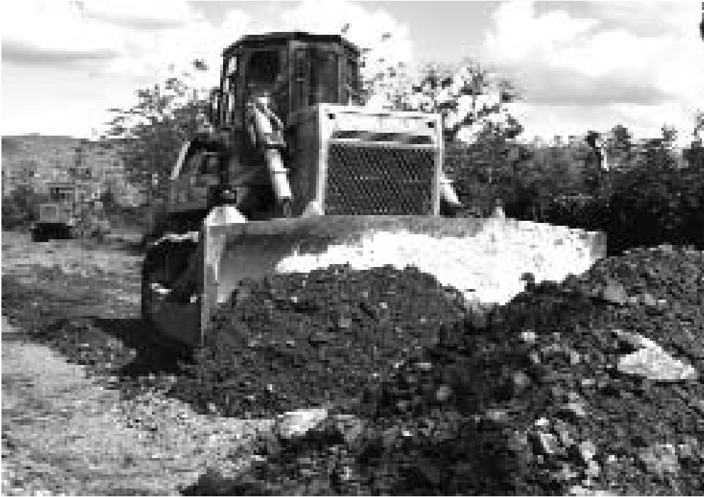
Instante en que se trabajaba sobre el kilómetro dos. FOTO DEL AUTOR
