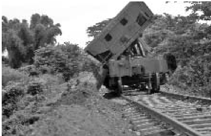
El empleo de material cercano a la zona dañada permitió abaratar los costos de la reparación del ramal. FOTO: OSCAR ALFONSO
