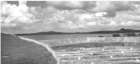
La reconstrucción del aliviadero de Dignorah implicó trabajos valorados en 1,7 millones de pesos. FOTO DEL AUTOR
