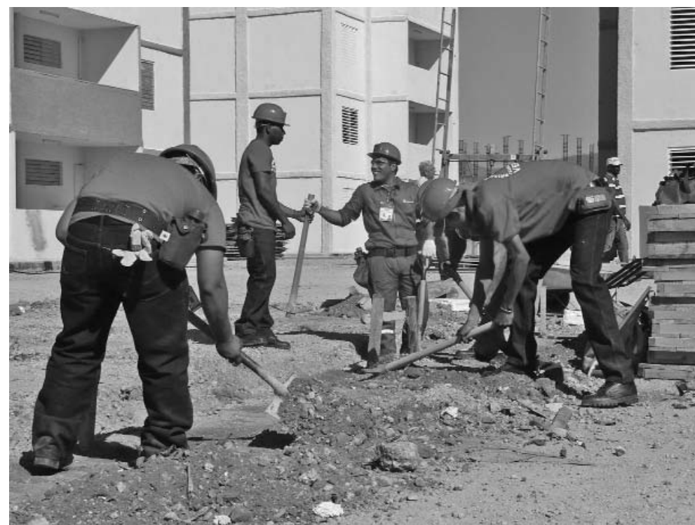
Bajo el fuerte sol la brigada se enfrenta a cualquier tarea constructiva.
