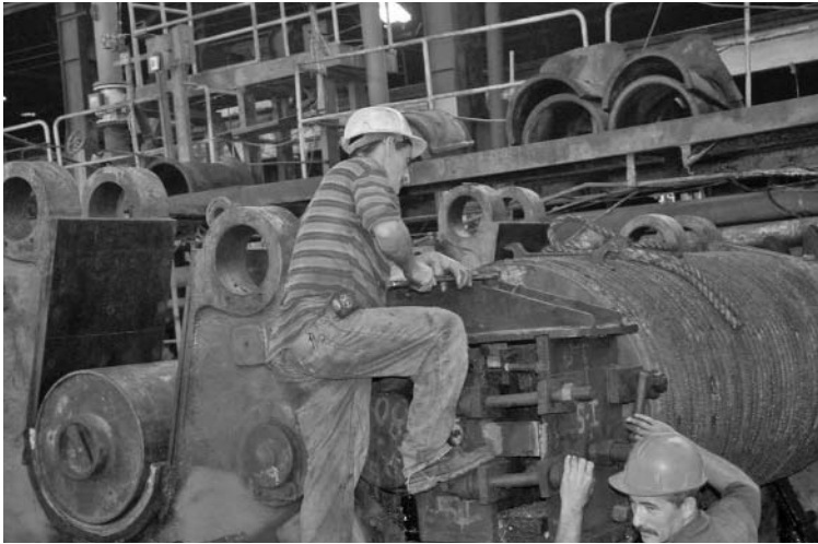
En el Uruguay pretenden concluir las reparaciones para el próximo 30 de noviembre. FOTO: VICENTE BRITO
