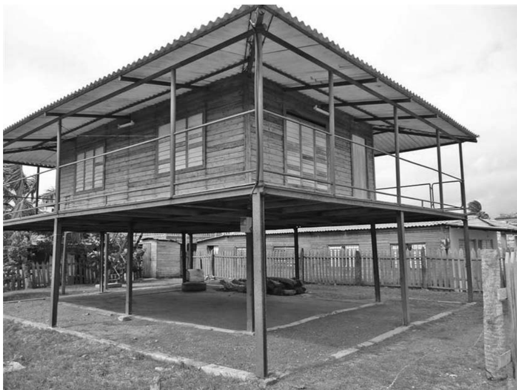
En edificaciones como esta, se comprobó la existencia de elementos de vías férreas en la ejecución.
