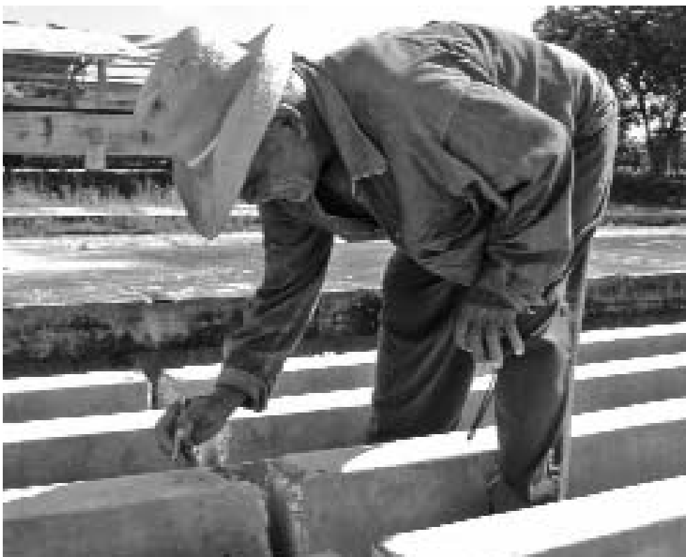
Con obreros como Jacinto Alonso Gallardo, cuenta la construcción para echar a andar la planta CUBA 71.
