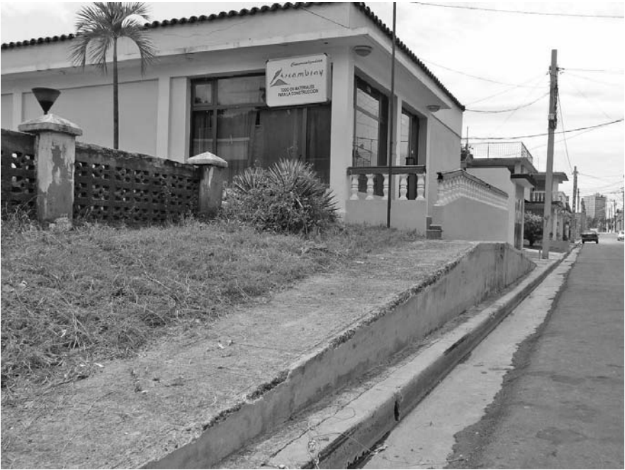
Ante la imponente rampa de la Comercializadora Escambray el transeúnte está obligado a subirla o tomar la calle. FOTO DEL AUTOR
