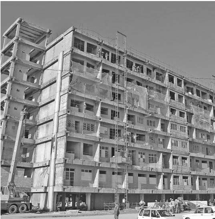
En la etapa inicial quedarán listas 98 viviendas del primer bloque habitacional.
