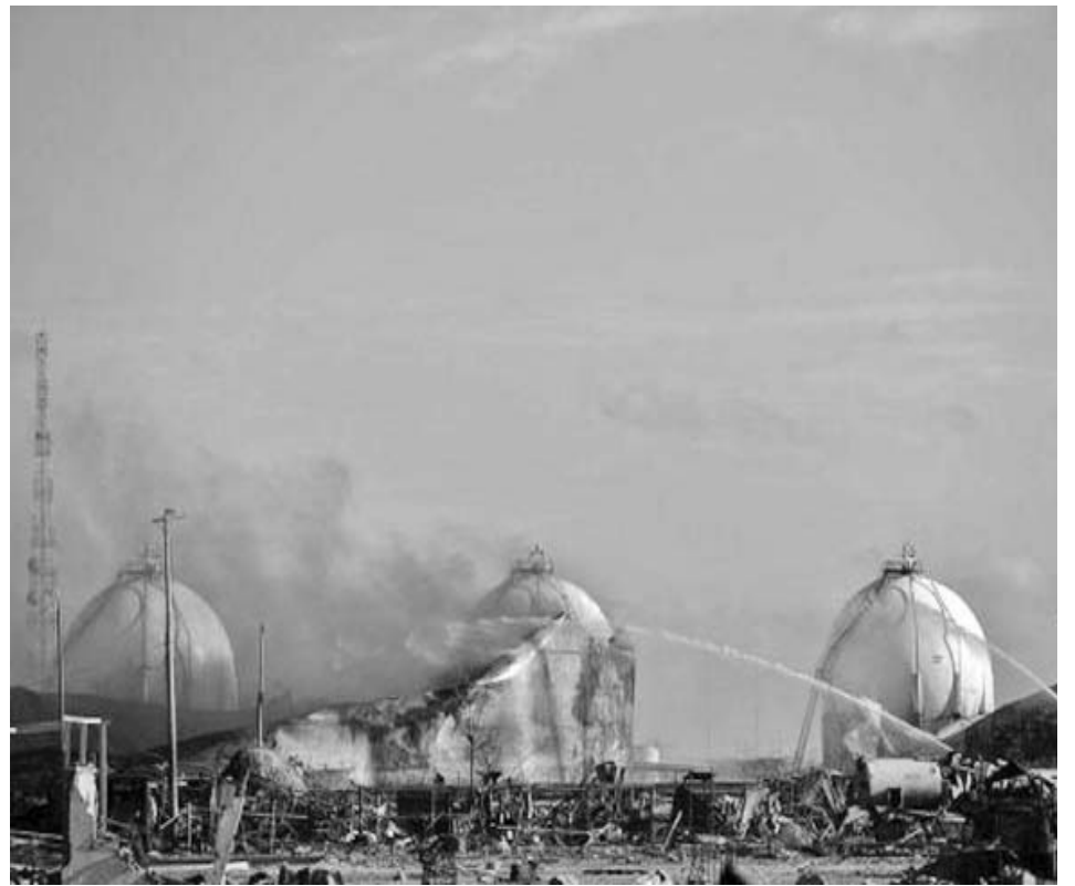
Los bomberos arrojan agua sobre las llamas que quedaban en algunos tanques de la refinería de Amuay, este martes, cuando el incendio quedó extinto. FOTO: AFP
