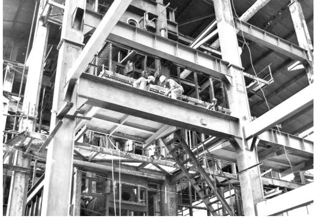
En el área de generación de vapor se montará una caldera nueva de 60 toneladas y se reparará otra de 40. FOTOS DEL AUTOR
