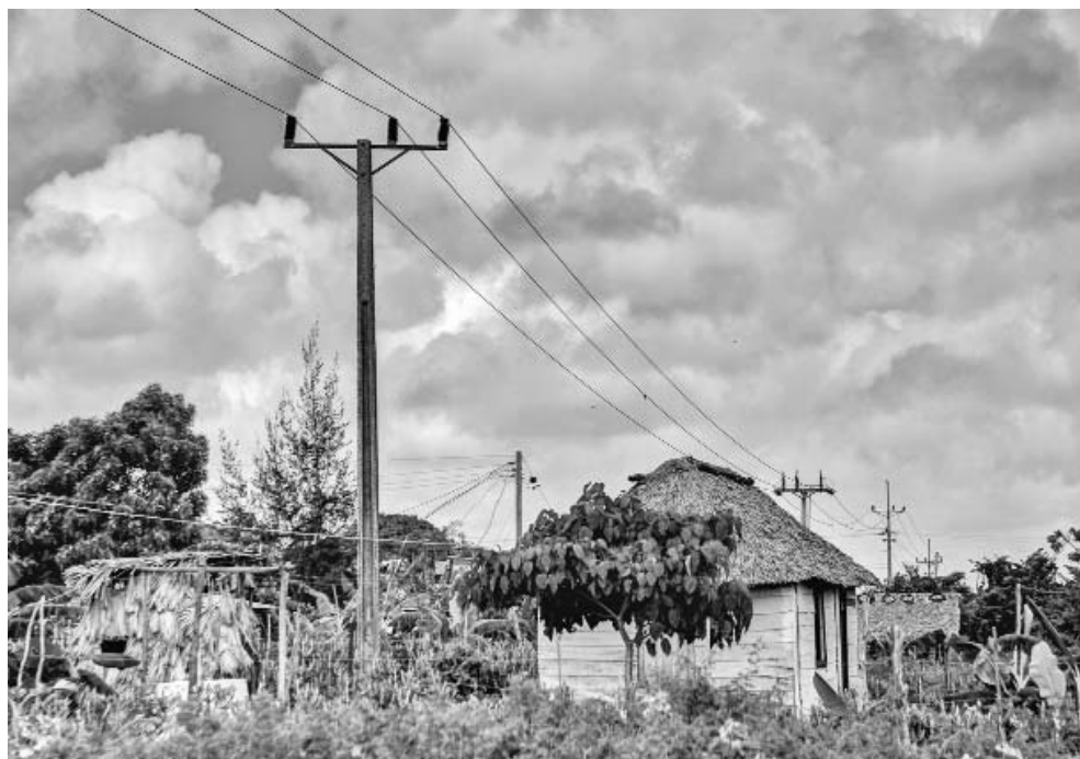
Típica invasión de la franja de seguridad de la línea de 33 mil voltios. FOTOS: JUAN PABLO CARRERAS/AIN
