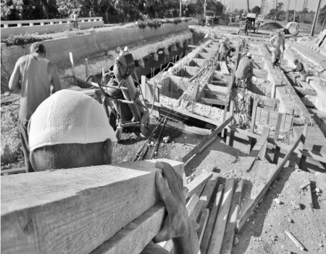
Trabajadores de la Empresa Constructora de Obras Ingenieras No. 5 acometen la reparación del puente sobre el río Mordazo.
