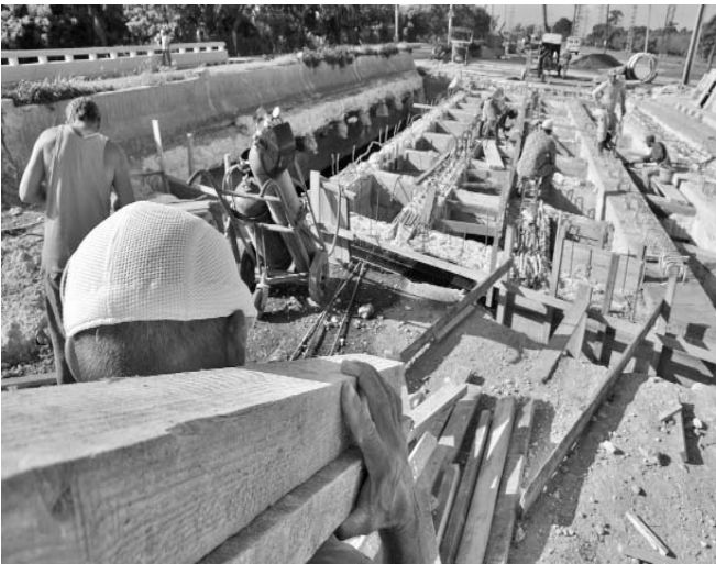
Trabajadores de la Empresa Constructora de Obras Ingenieras No. 5 acometen la reparación del puente sobre el río Mordazo. FOTO: RICARDO LÓPEZ HEVIA
