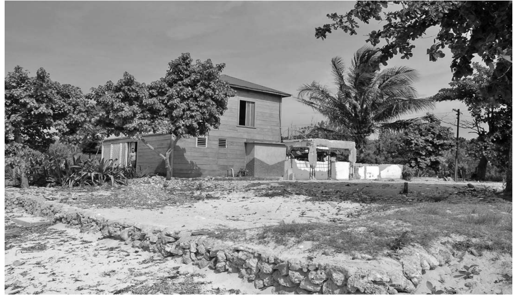
En primer plano es visible el sitio donde estuvo el restaurante El Cayuelo, en Guardalavaca. Progresivamente continuará la eliminación de inmuebles levantados sobre la duna.
