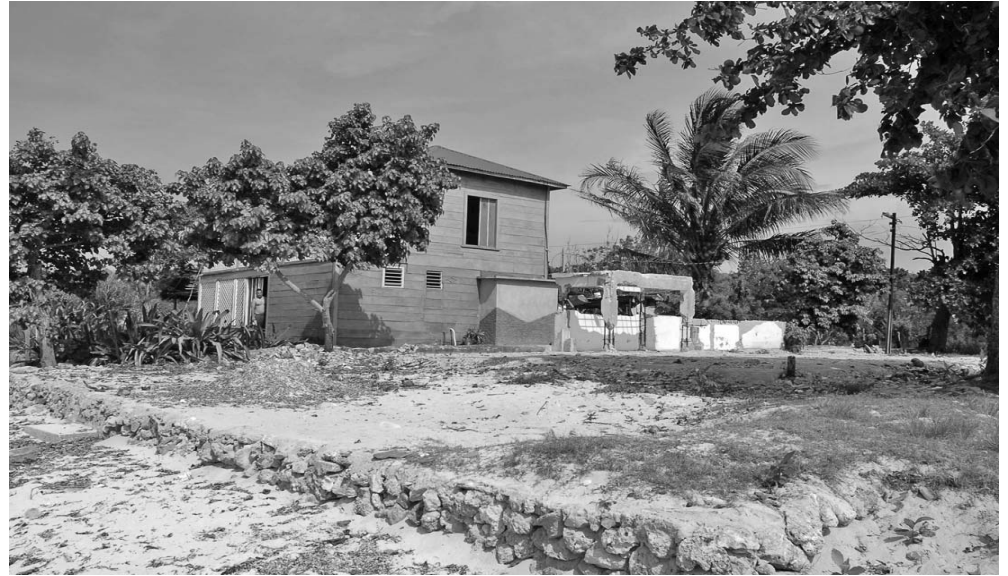
En primer plano es visible el sitio donde estuvo el restaurante El Cayuelo, en Guardalavaca. Progresivamente continuará la eliminación de inmuebles levantados sobre la duna.
