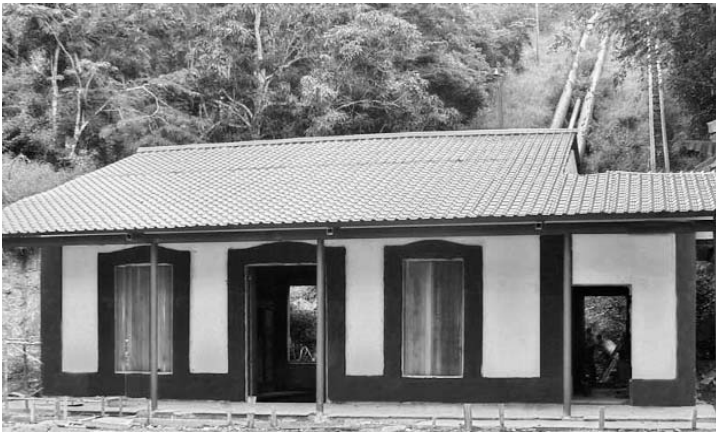
Con esta rehabilitación, Salto Pilotos alcanzará los 300 kW de potencia, alrededor de 200 kW más de los que contaba hasta ahora. FOTO DEL AUTOR
