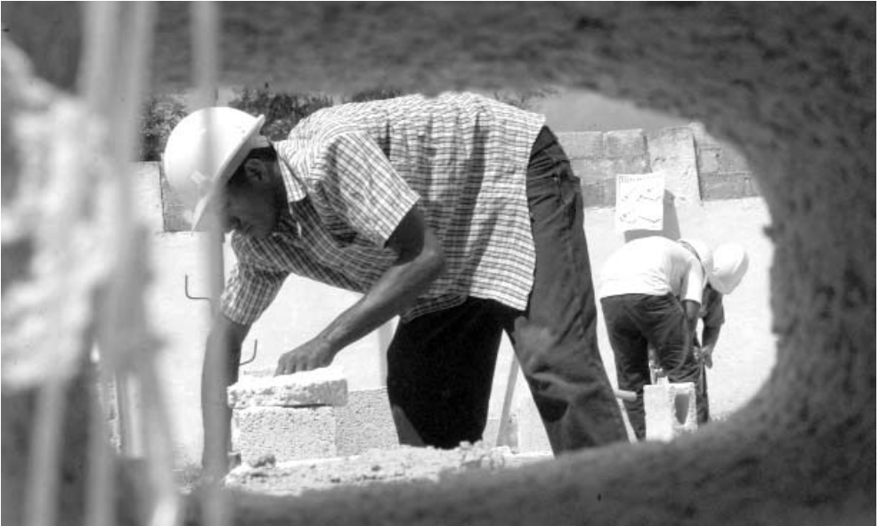
Un mejor conocimiento de las fuerzas, equipos y materiales permitirá concretar con mayor claridad las obras. FOTO: YAIMÍ RAVELO
