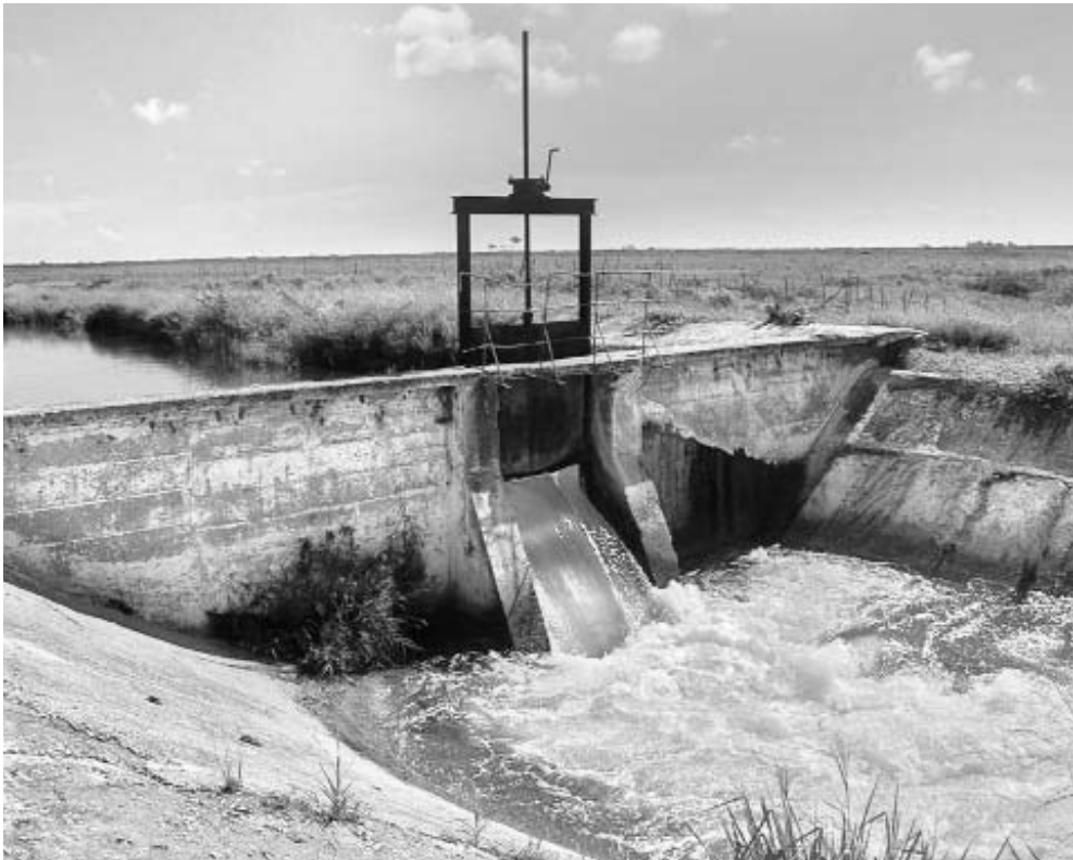
La reparación de compuertas y la sustitución de hidromecanismos figuran entre las acciones priorizadas para disminuir el consumo de agua en la arrocería.
