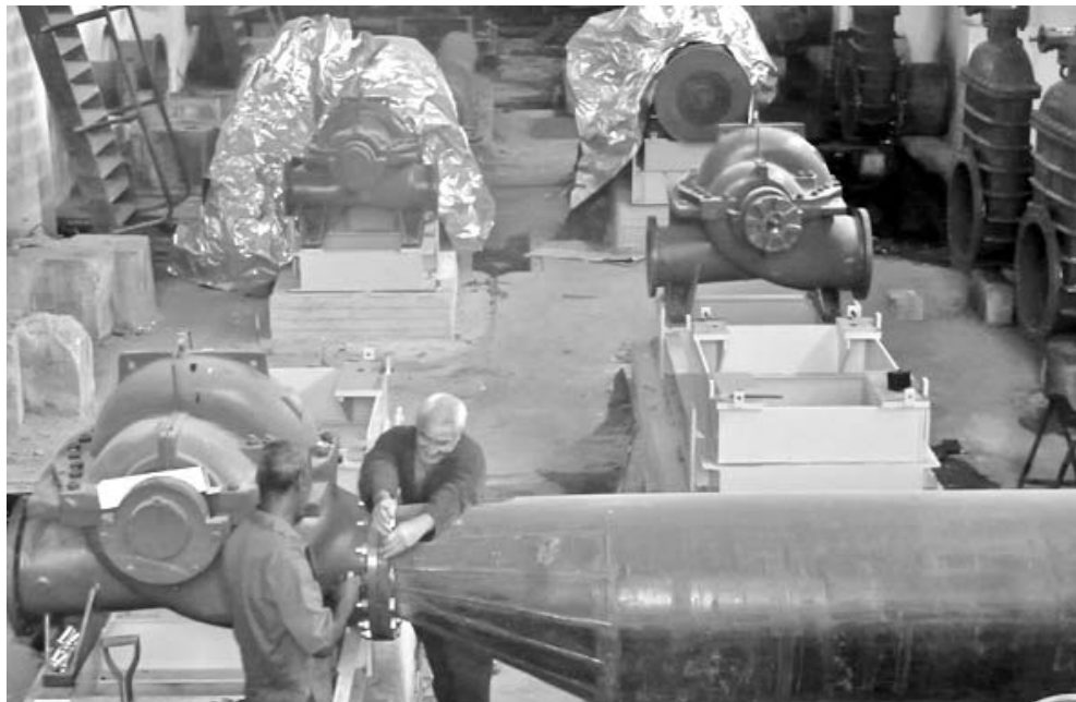
Montaje de las primeras electrobombas en la estación de bombeo La Yaya. FOTO DEL AUTOR
