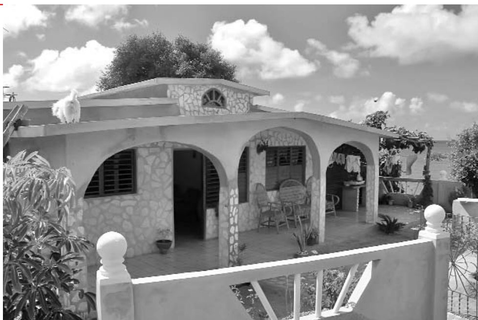
Tras el huracán Ike, sin licencia de construcción, construyeron paredes, cubierta de hormigón y muro perimetral.
