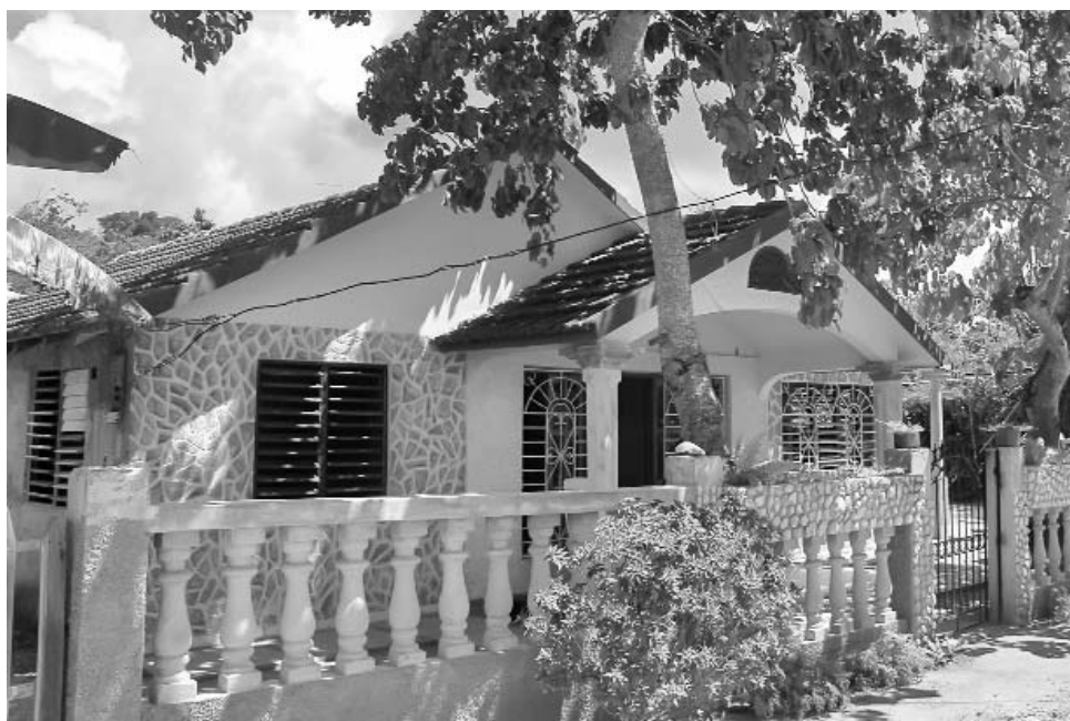
Sin autorización sustituyeron las tejas por placa de hormigón.
