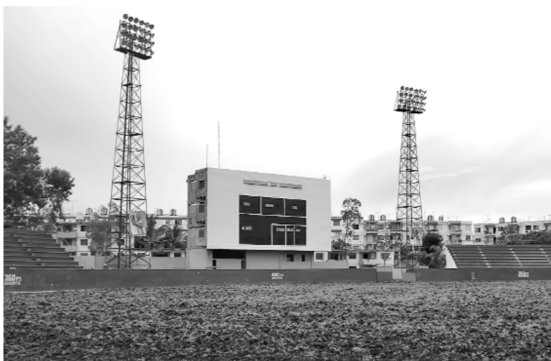
El terreno removido, listo para el relleno y la nivelación.
