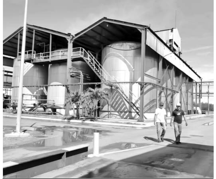
La planta recibió una reparación capital de su torre de enfriamiento y columna de destilación. FOTOS: JUAN CARLOS DORADO
