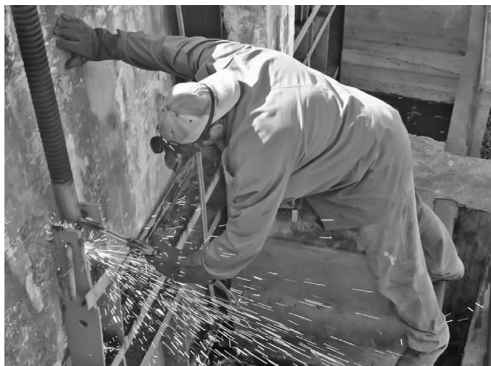
La reparación de las compuertas es una de las tareas acometidas.
