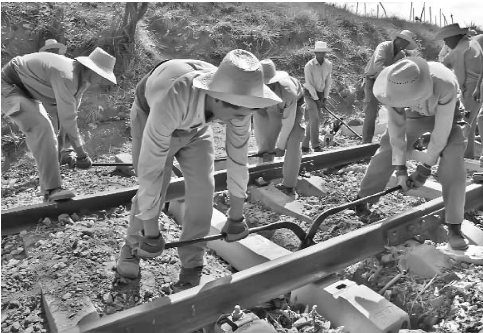
Los jóvenes soldados del EJT, como Miguel Ángel, Alejandro y Yoandy, constituyen un fuerte apoyo en la rehabilitación de las vías férreas. Foto: José M. Correa
