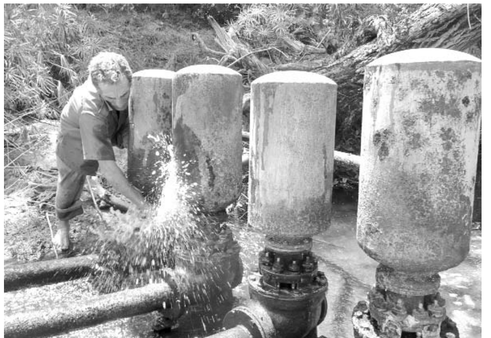
Sin mantenimiento sistemático, la vida útil de los arietes hidráulicos también disminuirá en las zonas serranas, donde se cree que es más económica la explotación.
