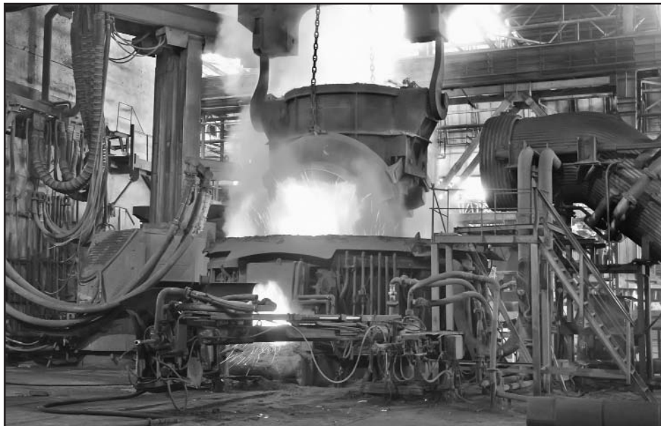
La reposición de las partes enfriables del horno y la incorporación de otra grúa deben disminuir considerablemente las roturas. Fotos: José M. Correa
