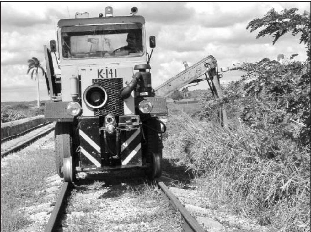
El auxilio de dos chapeadoras alivia el trabajo de las fuerzas del EJT y de los obreros del sector.
