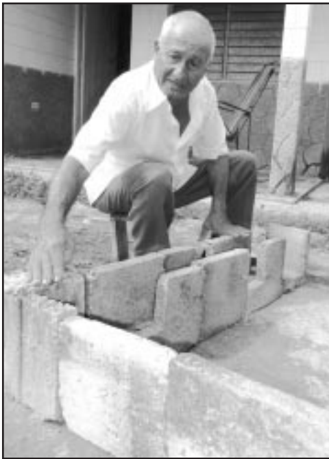
Daniel ejemplifica cómo se colocan los bloques en cuyo interior se funde el cerramiento.
