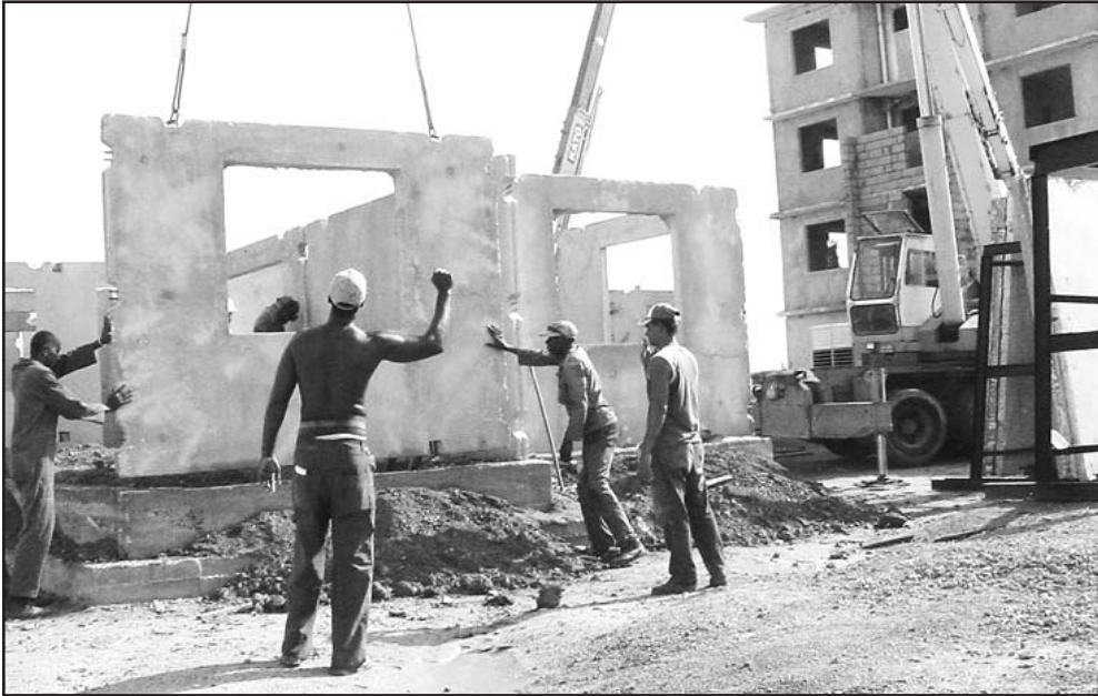
Poco a poco se recupera en Camagüey la construcción de edificios, como ocurre hoy en el Reparto Villa Mariana. Fotos: Otilio Rivero Delgado
