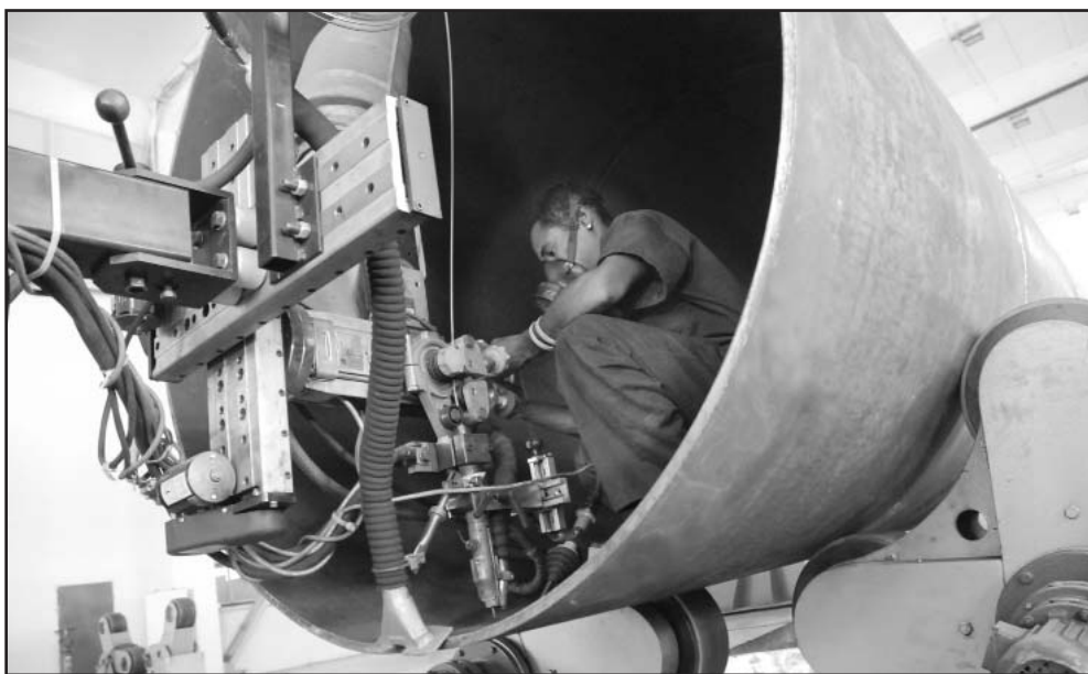
En el taller de la Base Central de Reparaciones, en Marianao, nace una chimenea tras otra. La nueva tecnología agiliza la producción. Fotos: Otmaro Rodríguez
