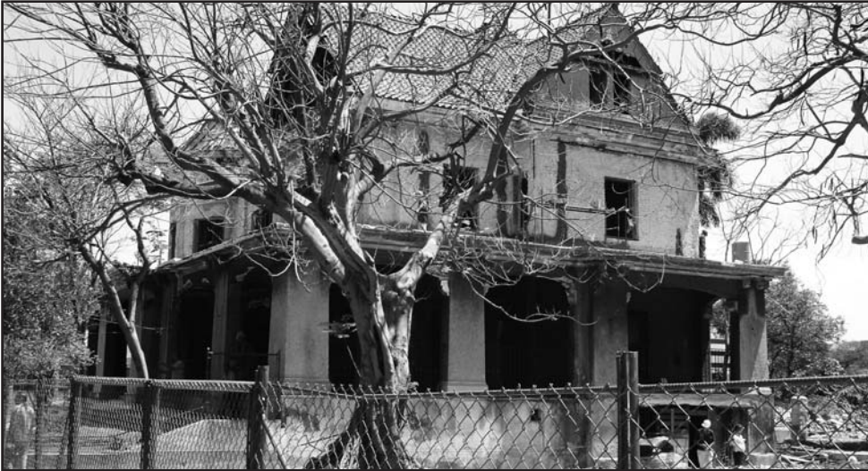
Estado del inmueble antes de su restauración.
