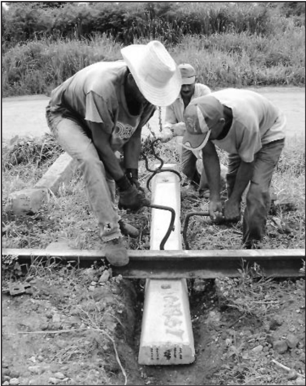
De la calidad con que sea repuesta cada traviesa dependerá la seguridad en el importante ramal.
