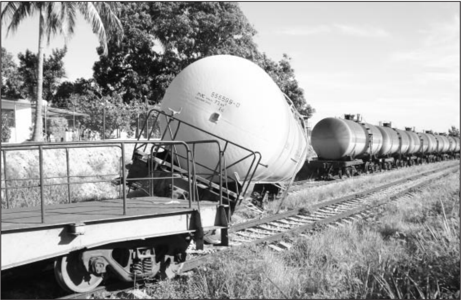
Los desperfectos que ocasiona en la vía la falta de alguno de sus elementos pueden provocar lamentables accidentes. En la fotografía se muestra el descarrilamiento de un tanque de combustible.
